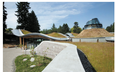
반두센 방문자센터의 지붕 모습. 아트리움이 있는 로비의 모습. 둥근 알루미늄판이 데워지면서 더운공기가 위로 올라간다. 두툼한 콘크리트담 위로 녹화된 지붕이 펼쳐진다. 지붕 한가운데 볼록한 곳은 구멍을 뚫고 천장을 설치한 아트리움이다.
